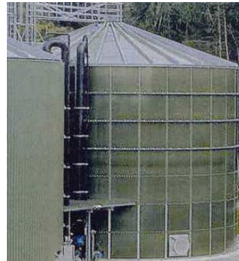
10. ábra Szegmentált, csavarozott, zománcozott nagytartály
