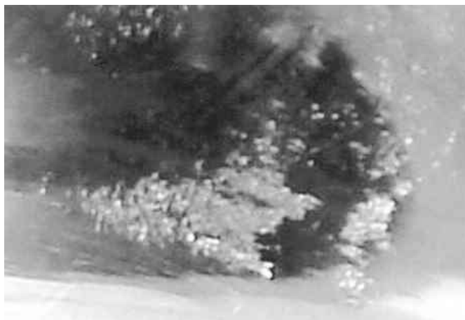
12. ábra A pontkorrózió kinagyított képe
